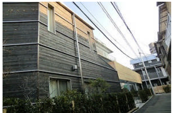
▲外断熱の外壁も焼杉を使用
